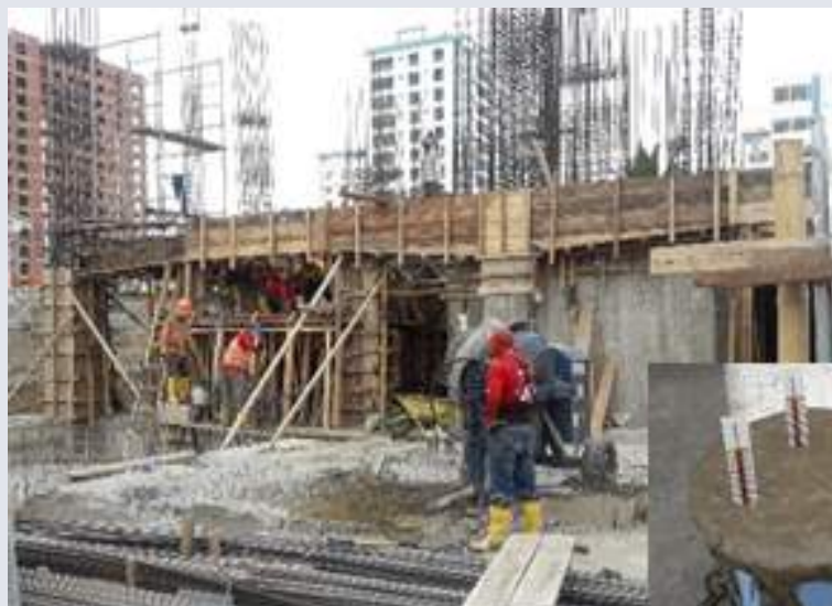
Sitio de construcción (Revisando contenido de cloruro en hormigón fresco)
